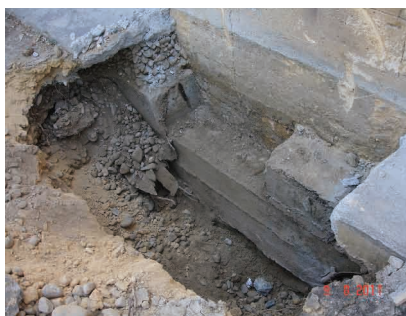
Φ. 3: Παλαιότερη επέμβαση στη θεμελίωση
