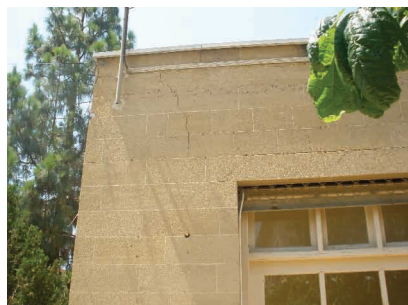
Φ. 5: Διαγώνια ρηγμάτωση στη Νότια γωνία
